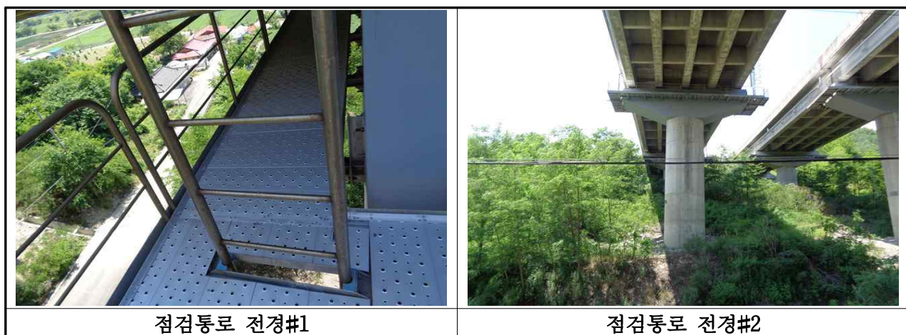
【사진 6.2】 점검시설 전경
