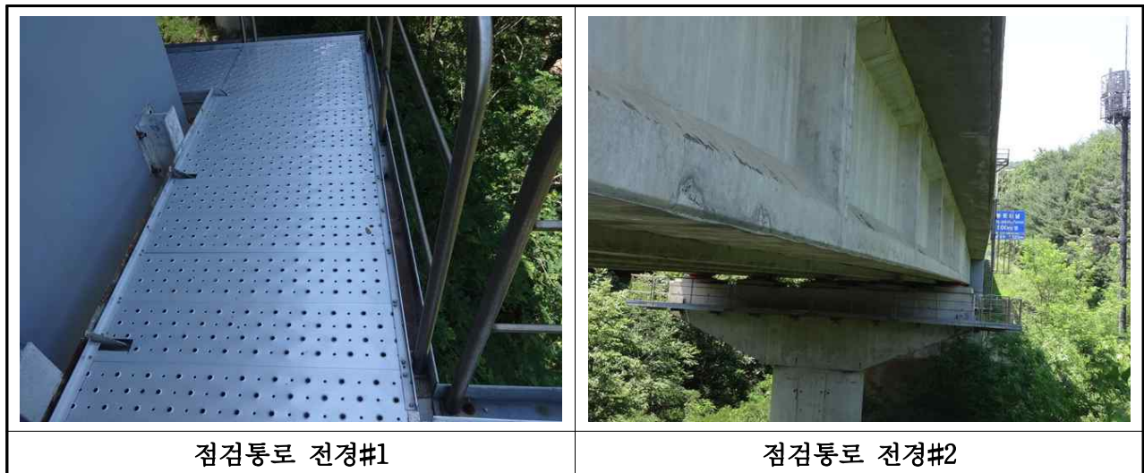
【사진 6.1】 점검시설 전경
